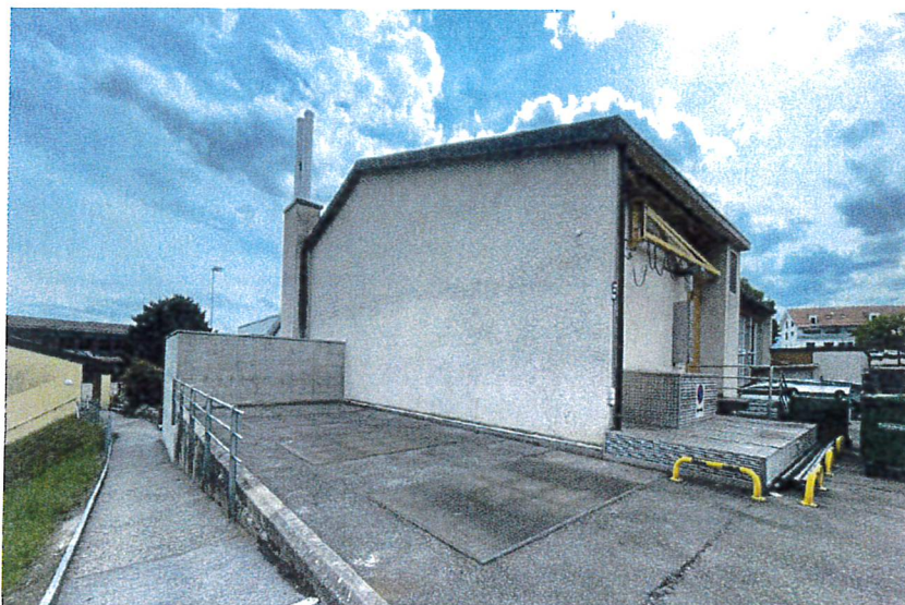
Emplacement prévu pour le nouveau bâti
