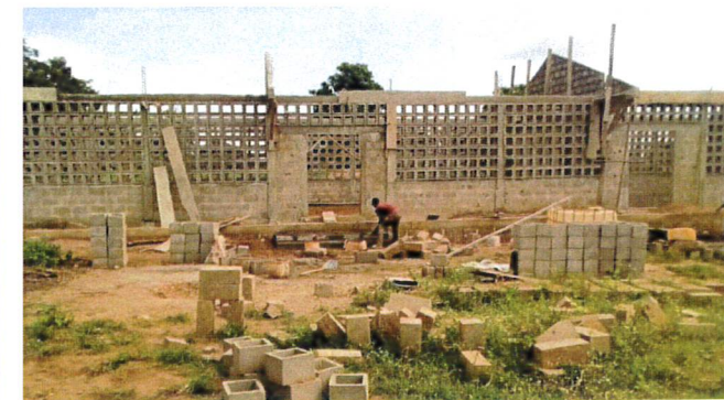
L'école en pleine construction !
