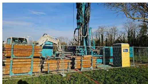
Plateforme de forage avec foreuse et équipements connexes : compresseur et tubes de foration, etc.
