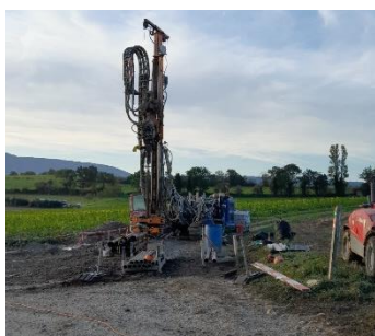
Plateforme de forage avec foreuse et équipements connexes : compresseur et tubes de foration, etc.
