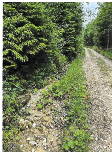
Les exutoires sont obstrués
